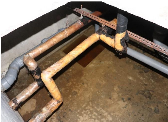
水道配管の状況
