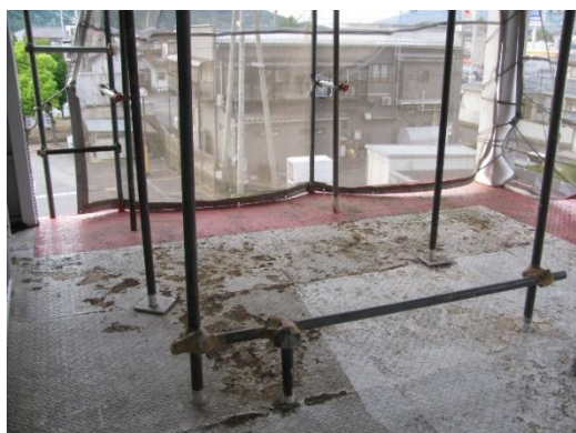
訓練塔の状況
